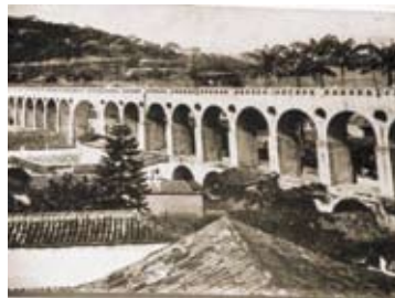
Foto 4 - Aqueduto transformado em viaduto para bondes (Rio de Janeiro, 1896).
