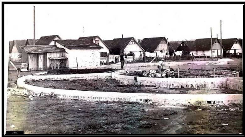
Figura 28 – Creche em construção – fase inicial
