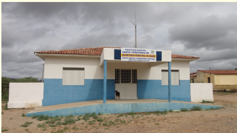
Figura 5 – Posto de saúde fechado para reforma na parte interna.
