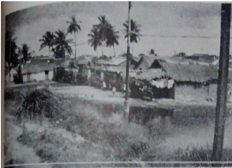
Imagem 02: Aspectos típicos dos mocambos na Cabanga. Habitações populares de tipo mocambo, casas feitas de barro e palhas. Arquivo Público Estadual Jordão Emerenciano (APEJE). Imagens do Boletim Técnico da Secretária de Viação e Obras Públicas. Boletim, vol. IV, nº 1, Janeiro a Março, 1941.
