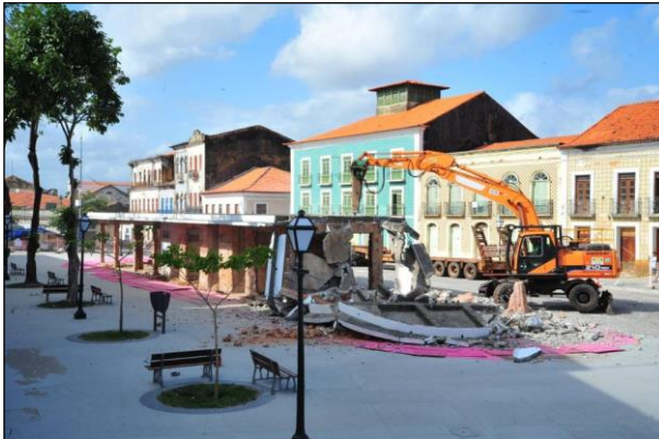
Figura 5 - Demolição do abrigo da Praça João Lisboa
