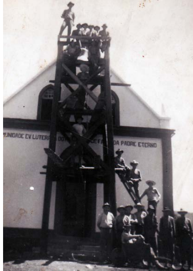
Imagem 5 - construção da torre em madeira
