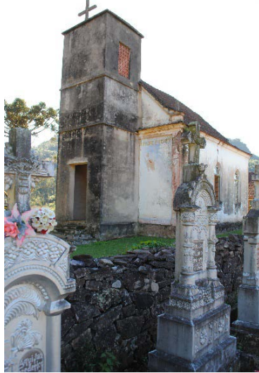
Imagem 2 – Vista da igreja a partir do cemitério
