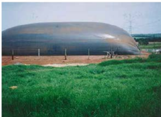
Figura - 3 Biodigestor modelo canadense
