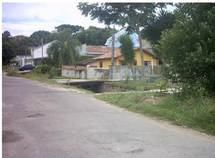
FIGURA 2 – ÁREA COM RISCO DE ENCHENTES (RUA JOANA EMMA DALPOZZO ZARDO - PORÇÃO NOROESTE)
