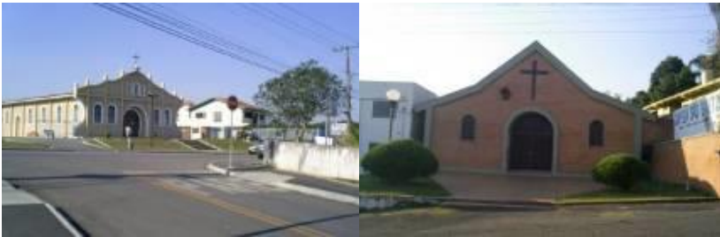
Figura 10: Igreja Santa Margarida fonte: O Autor Figura 11: Capela São Bartolomeu Fonte: o autor
