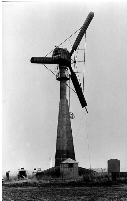
Aerogerador dinamarquês Gedser da década de 1950. Fonte: https://commons.wikimedia.org
