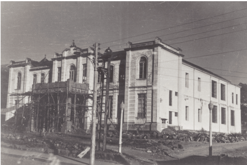
Figura 25. Obras de reforma do prédio da FMTM, [1960]
