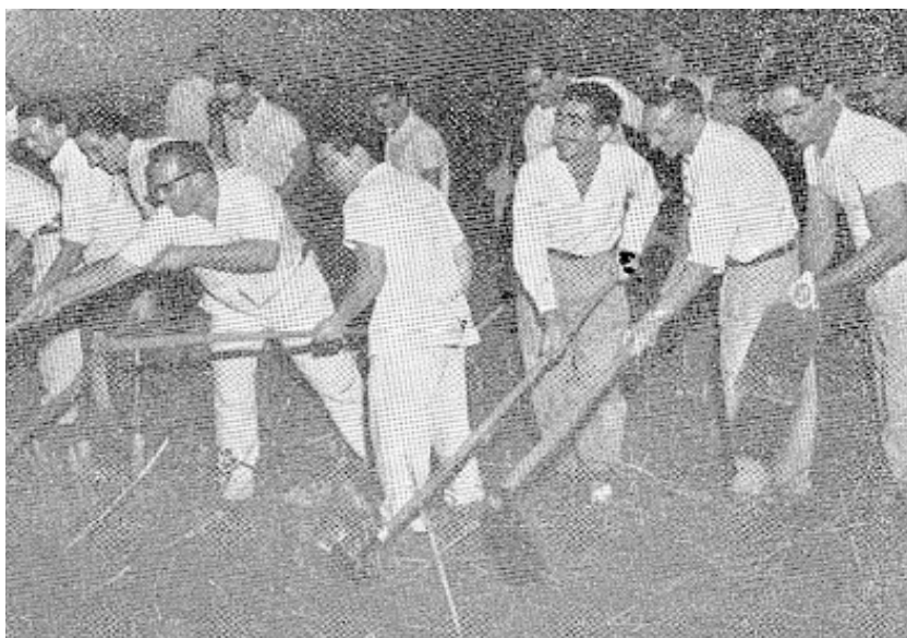
Figura 24. Alunos da FMTM se entregam às atividades de reforma do prédio [1959]
