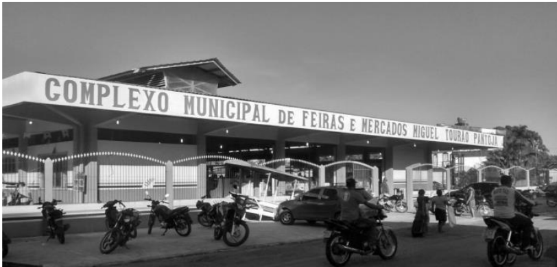
Complexo Municipal de Feiras e Mercado de Igarapé-Miri Fonte: Autor (2016).
