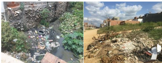
Imagem 2 – Problemas na infraestrutura urbana
