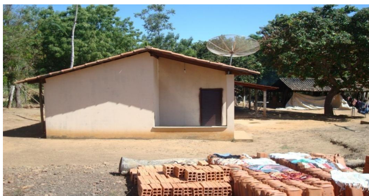
Figura 13 - Vista externa da residência (banheiro com a porta pelo lado de fora)
