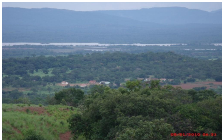
Figura 8 - A Comunidade Malhadinha após a construção da Usina Hidrelétrica. O lago em primeiro plano
