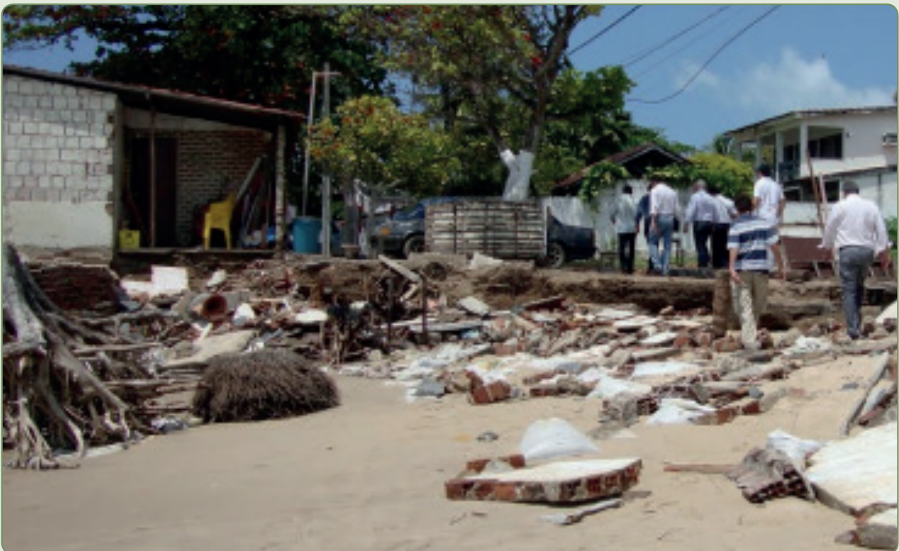
Figura 6.1 – Destruição provocada pela erosão costeira no litoral de Paulista (PE)
