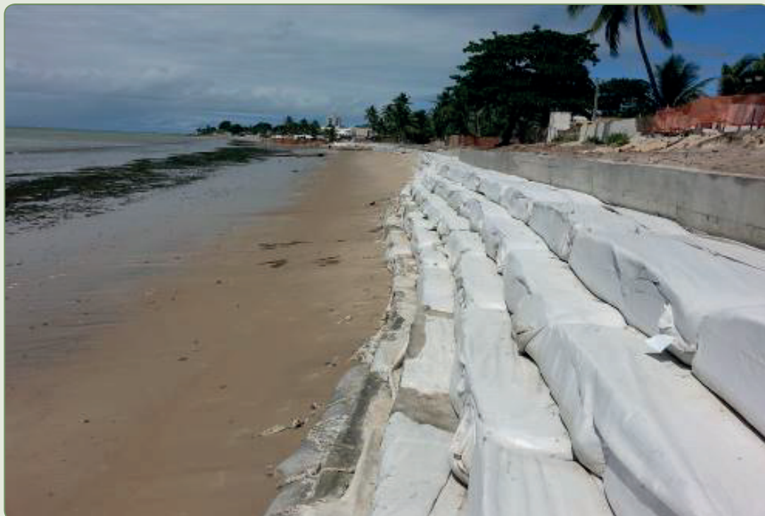
Figura 6.3 – Estrutura rígida ( bagwall ) construída ao longo da orla do município de Paulista (PE)
