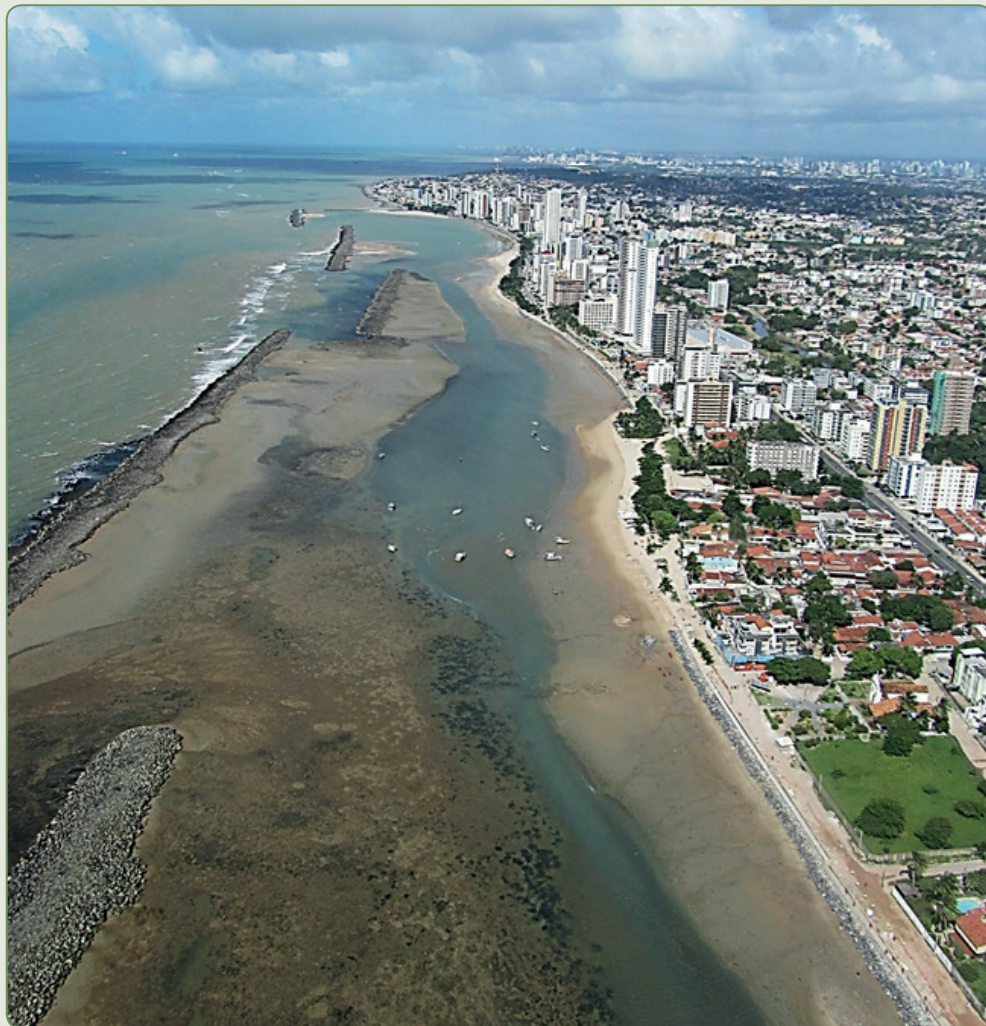
Figura 2.8 – Quebra-mares construídos paralelamente à linha de costa na Praia do Rio Doce, município de Olinda (PE)*
