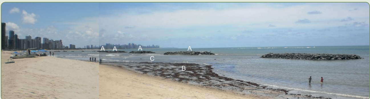
Figura 7.5 – Configuração do quebra-mar em uma maré baixa de sizígia (31 de março de 2014)
