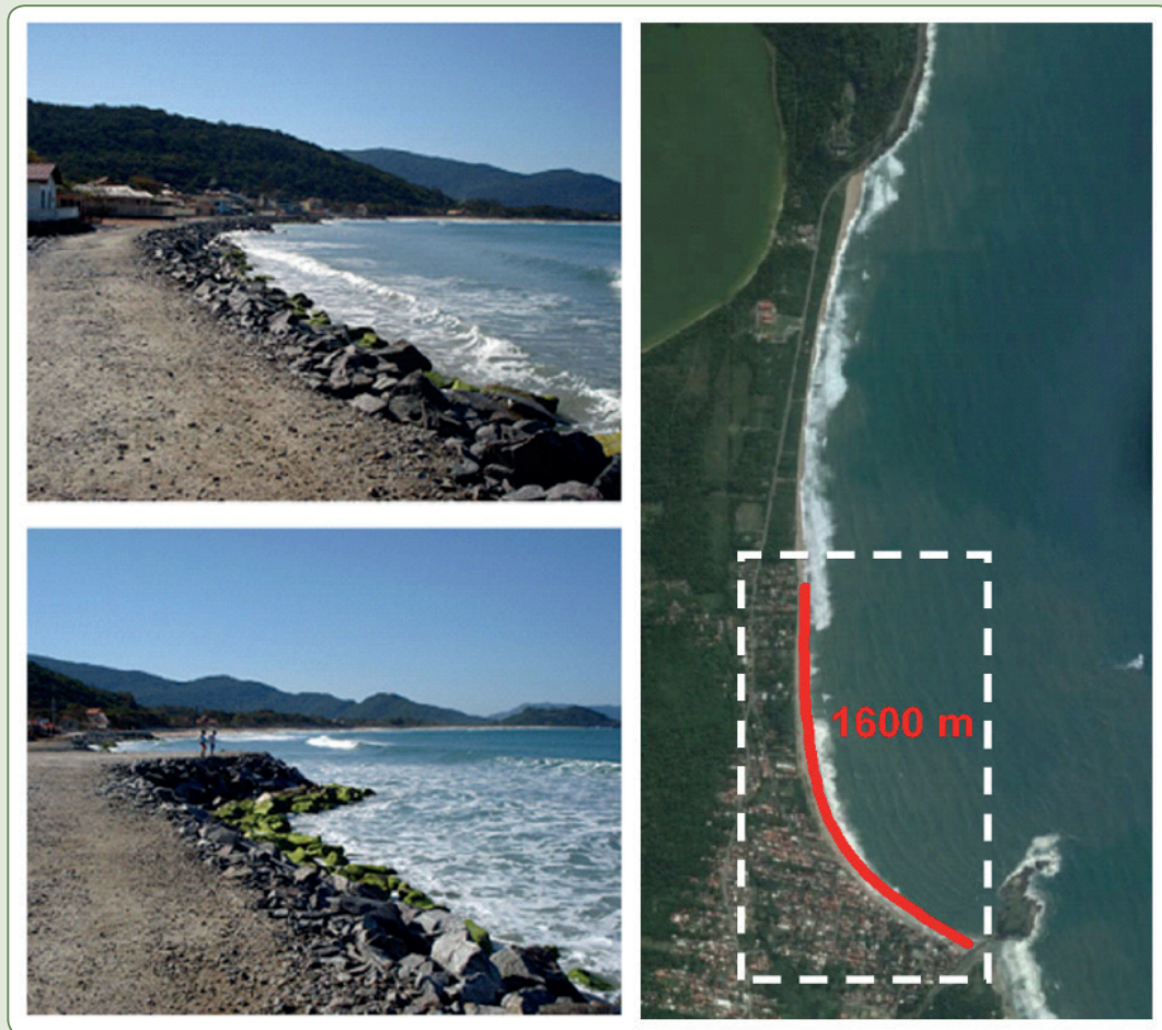
Figura 15.1 – Enrocamento construído na área urbanizada da Praia da Armação
