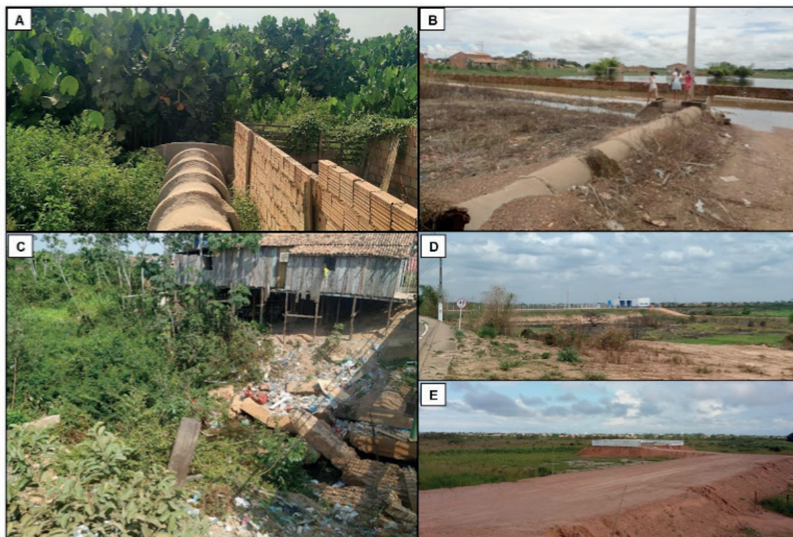
Figura 2: No mosaico em A) vegetação x expansão urbana ondeo descarte de efluentes pelo poder público municipal na área; B) tubulações da precária rede de esgotamento com tráfego de pessoas sobre ela durante as cheias em fevereiro de 2018; C) Descarte de resíduos sólidos em drenagens pluviométricas e residências nas cercanias e em D e E) Início das obras da Estação Elevatória foto registrada em 2018, o aterramento e uma parte ainda com água sobre a superfície próximo a vegetação e a situação atual da construção.
