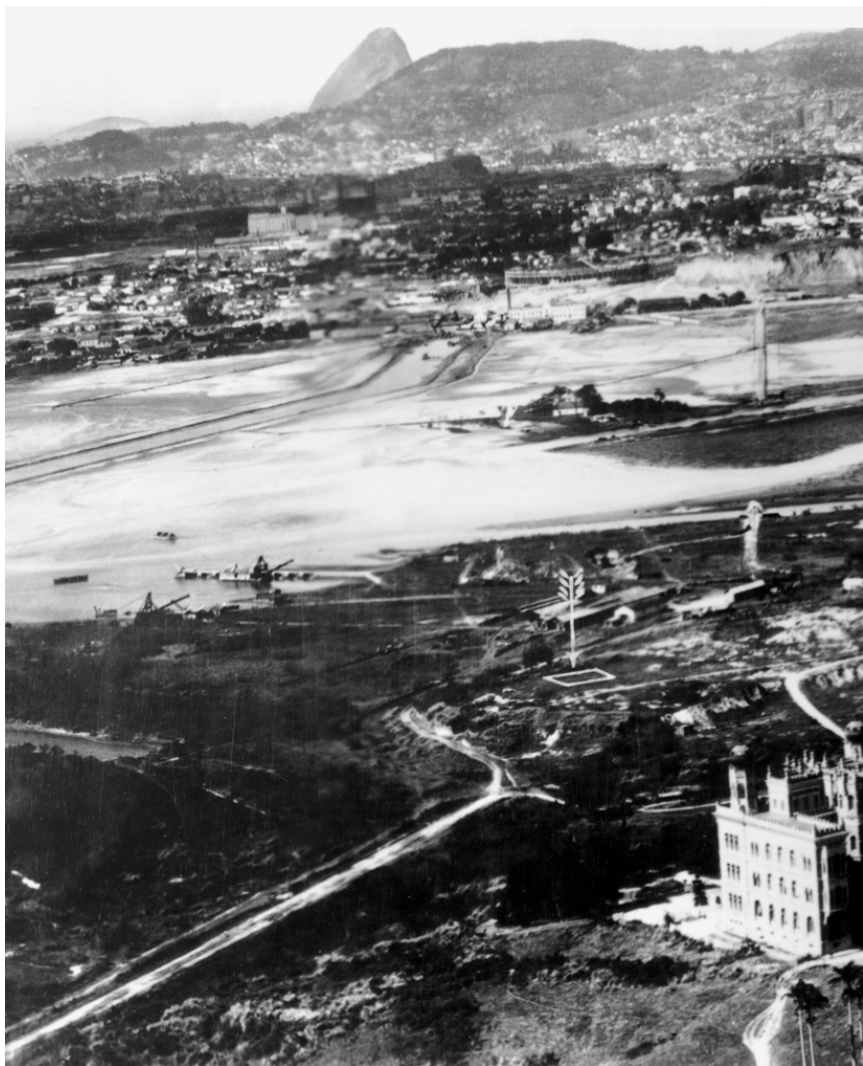
Local (indicado por uma seta) reservado à construção das instalações do futuro laboratório da Fundação Rockefeller, no campus de Manguinhos. Rio de Janeiro, outubro de 1936.
