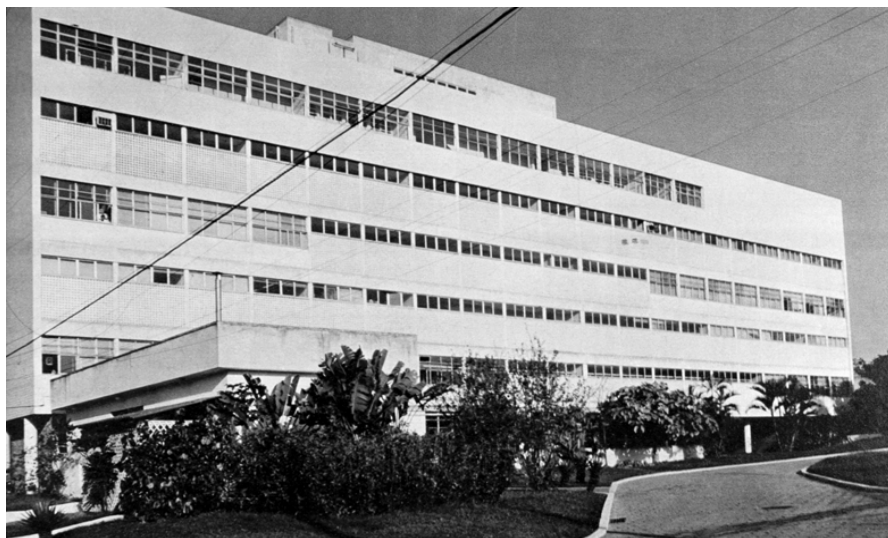
Pavilhão Rocha Lima, que abriga o Instituto de Tecnologia em Imunobiológicos da Fundação Oswaldo Cruz/Bio-Manguinhos. Rio de Janeiro, RJ, 1983.
