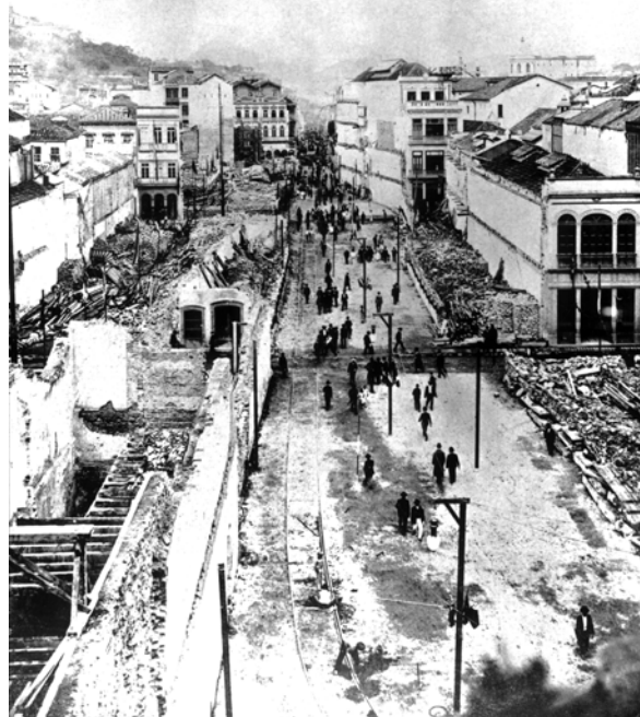
Trecho das demolições para a abertura da avenida Central, entre as ruas General Câmara e Santa Luzia. Rio de Janeiro, RJ, cerca de 1904. Reprodução/Coc/Fiocruz
