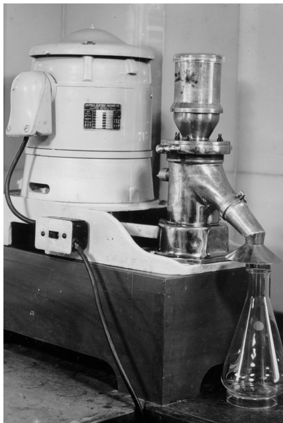
Moinho coloidal usado na trituração dos embriões, adotado a partir de 1942 em substituição ao moinho de bolas. A nova máquina era capaz de triturar melhor e em menos tempo. Rio de Janeiro, RJ, 1941-1943. Manual da Vacina/LAFA/Bio-Manguinhos/Fiocruz
