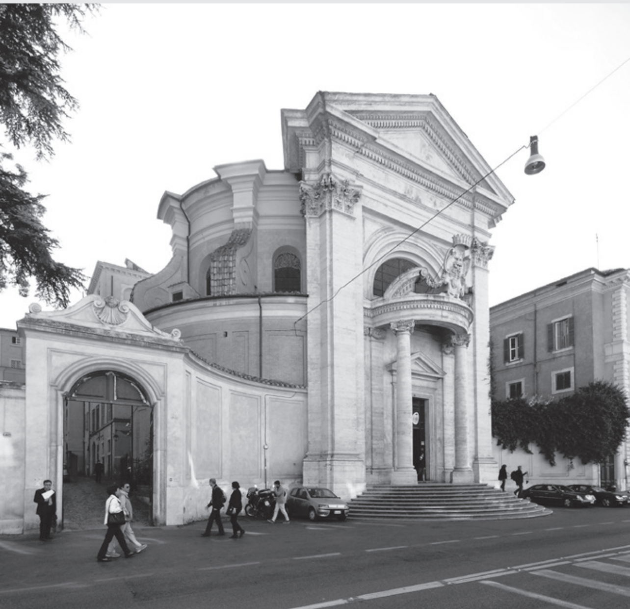
181. Fachada da Igreja de Sant'Andrea al Quirinale. Projetada por Gian Lorenzo Bernini e construída entre 1658 e 1670. Os muros côncavos da fachada produziram uma forte sensação de acolhimento no recuo gerado na estreita Via del Quirinale (antiga Strada Pia) e atrairiam o fiel para seu espaço interno através da escadaria que invadiria, categoricamente, o espaço da via. Para além disso, a concavidade dos muros entraria em oposição com a convexidade da escadaria, com a poderosa fachada clássica e com a própria forma elíptica do edifício – revelada por detrás de toda a composição. Fonte: Fotografia elaborada pelo autor (2011).
