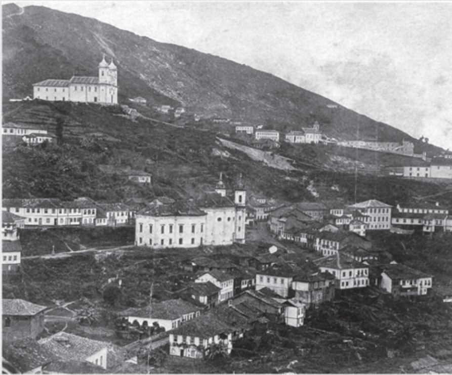
257. Panorama do Bairro do Rosário em 1875. Reparar a relação entre a mancha edificada, os monumentos livres de edificações e a paisagem natural. Em destaque, a Igreja de Nossa Senhora do Rosário (abaixo), a Igreja de São Francisco de Paula (acima) e a Igreja de São José (à direita). Fonte: Acervo IFAC/UFOP.
