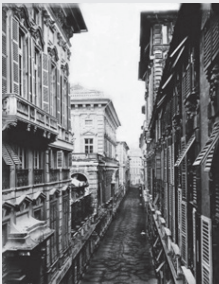
36. Via Nuova, em Genova, em fotografia do século XIX. Imagem elaborada por Alfred Noack (1833-1895). A via foi aberta na segunda metade do século XVI e poderia ser considerada como uma das primeiras intervenções que antecipariam a urbanística barroca. Fonte: Wikimedia Commons contributors.
