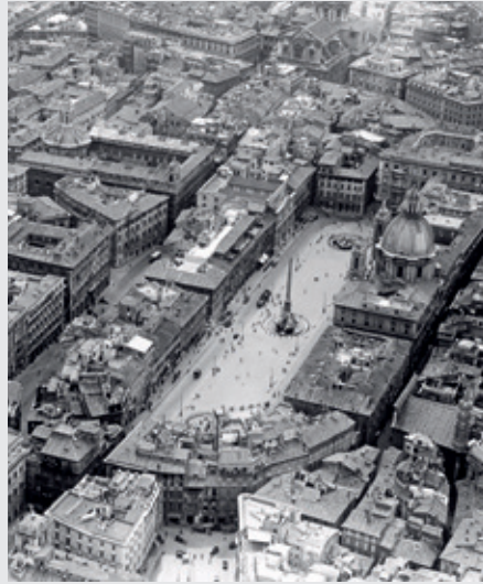
185. Fotografia de 1930 da aérea da região do Pantheon e da Piazza Navona. É interessante notar como tanto o vazio da praça como os quarteirões que a circundam seguem rigorosamente o desenho do antigo Circo Agonale. Em destaque, a Fontana del Moro (acima) e a Fontana del Nettuno (abaixo). Também em destaque, marcando o centro da praça, a Fontana dei Quattro Fiumi com seu obelisco – mas também a Igreja de Sant’Agnese com suas esbeltas torres e alta cúpula. Fonte: Site Roma ieri oggi .
