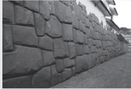
334. Casarões coloniais cusqueños construídos acima de alicerces e de muros incas remanescentes. Fonte: Fotografia elaborada pelo autor (2007).
