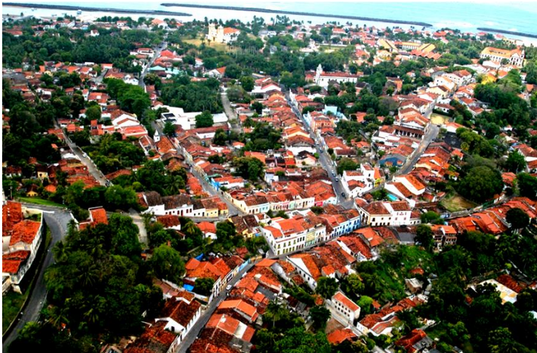
Figura 04 - Vista superior do SHO
